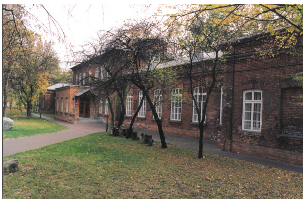
Ryc. 1. Budynek Działu Zbiorów Specjalnych GBL na terenie dawnego Szpitala Ujazdowskiego
