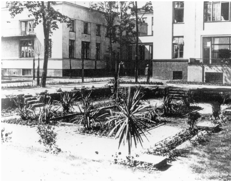
Ryc. 13. Instytut Radowy od strony ogrodu. Po lewej – budynek rentgenoterapii, po prawej – główny budynek kliniczny
