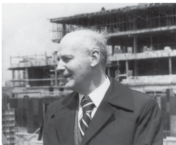
Prof. Tadeusz Koszarowski na budowie Centrum Onkologii na Ursynowie – lata 80 ub. wieku
