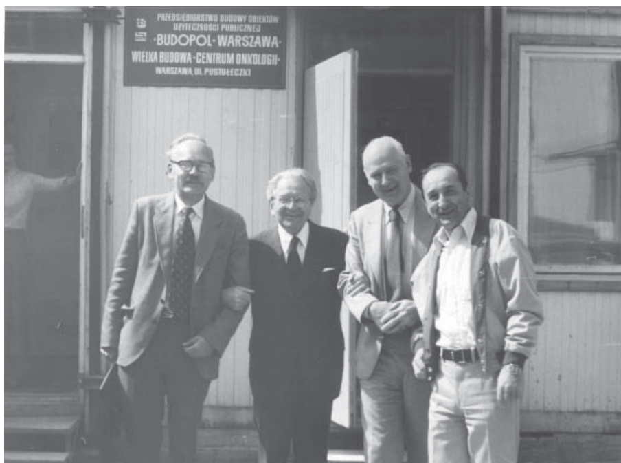
Ryc. 8. Na budowie Centrum Onkologii J. Steffen, S. Wesołowski, T. Koszarowski, A. Kułakowski (1986 r.)
