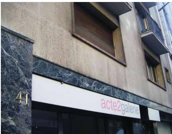
Ryc. 6. Widok frontu budynku przy No.41 rue d'Artois; dziś jest to galeria sztuki (fot. René Van Tiggelen)
