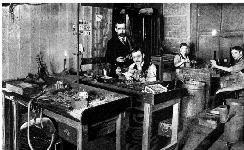
Rycina 3. Wytwarzanie lamp Crookesa w pracowni A.C. Cossora, uważanej wówczas za czołową wytwórnię w Zjednoczonym Królestwie. Jej ogłoszenie znalazło się m.in. w drugim wydaniu podręcznika Snowdena Warda z 1898 roku. Mieściła się pod tym samym adresem, co wydawca The Photogram — Dawbarn & Ward
