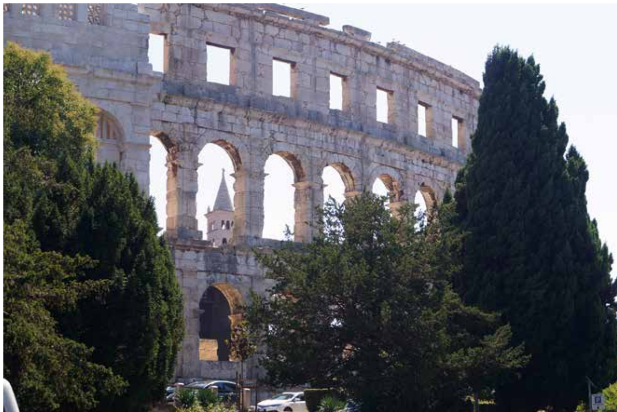
Pula państwa Cesarza Augusta — przy forum wznoszono świątynie i inne monumentalne budowle
