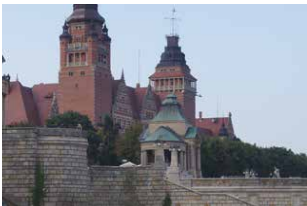
Fotografia 2. W latach 1902–1921 powstały budzące do dziś wielki podziw monumentalne Tarasy Hakena, zwane obecnie Wałami Chrobrego
