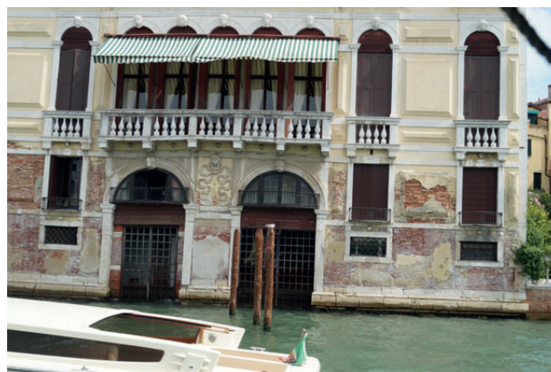
Fotografia 6. Stare budynki, atakowane przez zanieczyszczone morze, ulegają zniszczeniu
