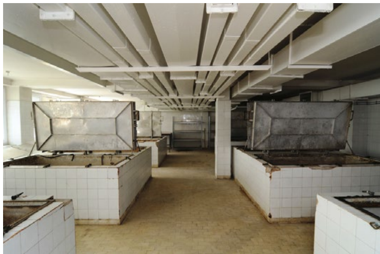
Miejsce przechowywania zwłok przed remontem pozostawiało wiele do życzenia, a praca w tych warunkach była bardzo trudna i fizycznie wyczerpująca
