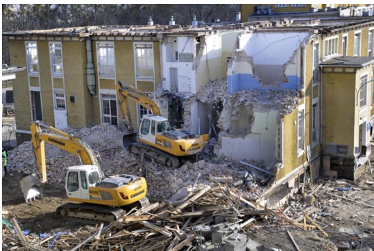
Rozbórka budynku nr 22 dawnej siedziby Kliniki Dermatologii (22.03.2016 r.)
