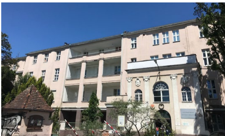
Szpital przy ul. Klinicznej (wejście główne)
