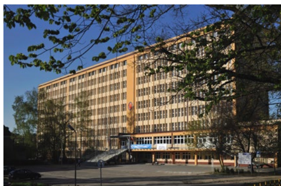
Ryc. 13. Budynek Collegium Biomedicum po termomodernizacji
