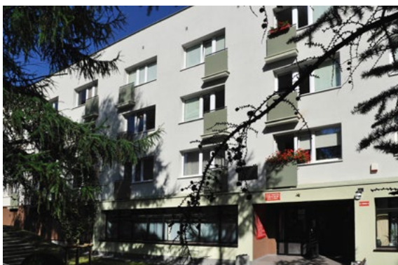
Ryc. 17. Budynek Dziekanatu Wydziału Nauk o Zdrowiu
