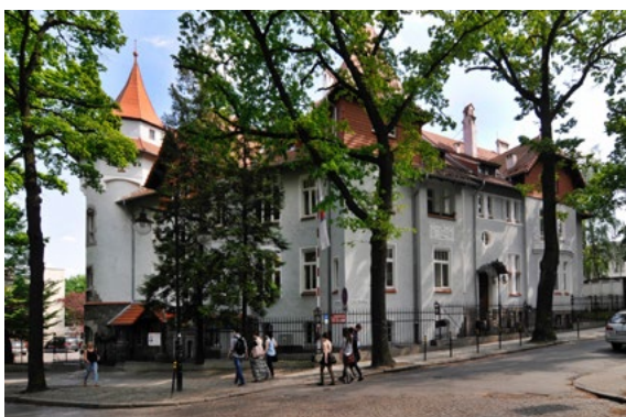
Ryc. 18. Budynek rektoratu po odnowieniu
