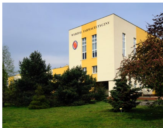
Ryc. 12. Wydział Farmaceutyczny po wykonanej termomodernizacji
