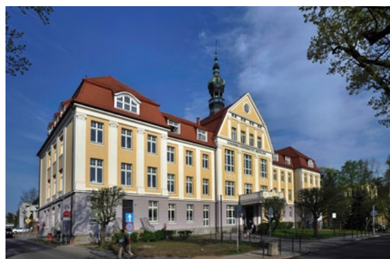
Ryc. 9. Budynek nr 1 po termomodernizacji
