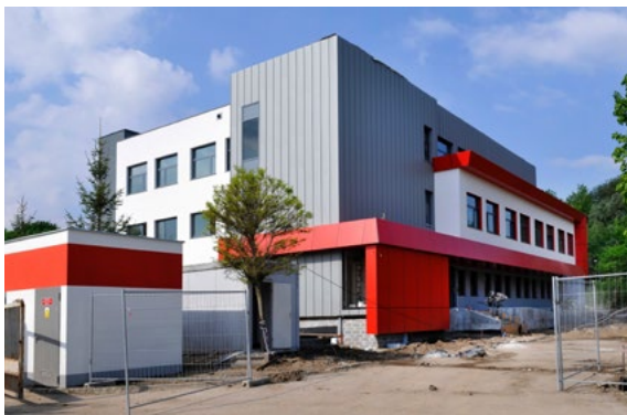
Ryc. 15. Budynek starej pralni po całkowitej przebudowie na potrzeby Katedry Mikrobiologii
