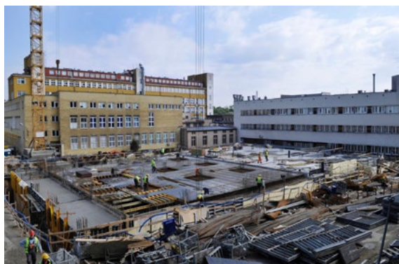
Ryc. 8. Praktycznie na ukończeniu są prace nad pierwszym etapem poziomu -1 pod budynek D dla Katedry Onkologii i Radioterapii oraz Zakładu Diagnostyki Izotopowej
