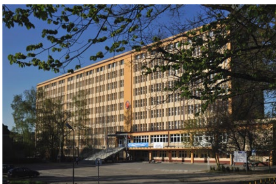
Ryc. 13. Budynek Collegium Biomedicum po termomodernizacji
