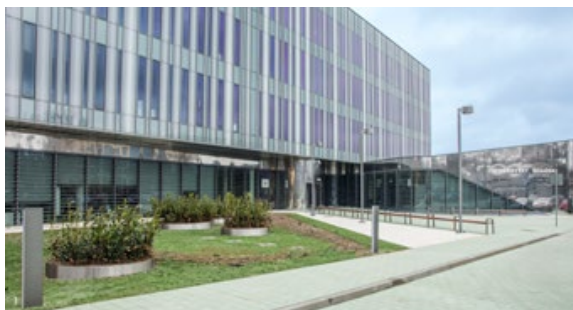
Gmach Instytutu ma prawie 8000 m 2 powierzchni użytkowej, 4 kondygnacje naziemne i 1 podziemną
