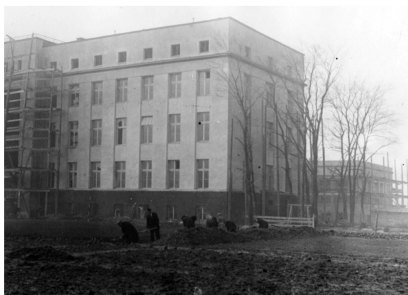
Rycina 7. Budynek pracowni naukowych Instytutu Radowego – prace wykończeniowe (ze zbiorów Narodowego Archiwum Cyfrowego)
