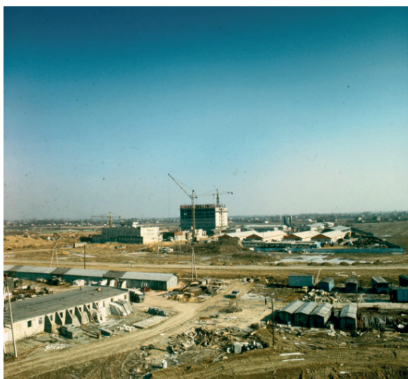
Rycina 29. Budowa nowej siedziby Instytutu Onkologii na Ursynowie, koniec lat 70. (ze zbiorów Redakcji Naukowej NIO-PIB)
